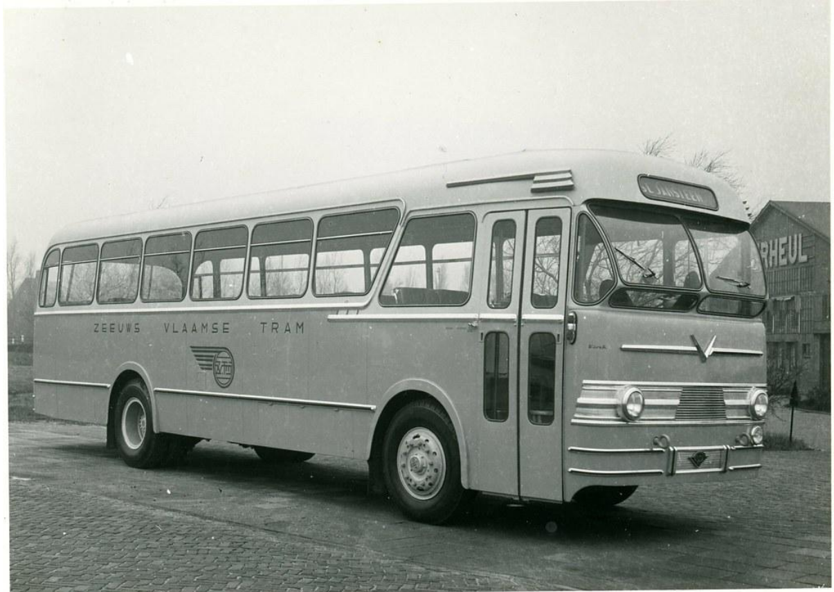
ZVTM 28 (Vink) Guy Arab LHUF/Verheul 1957 (rooster in grille) Aantal personen (zit/sta) : 46/06 met gebolde voorruit in het bovendeel
